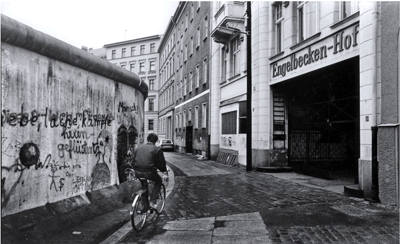
Turm, Eingang zur Mauer, da wo der Golf steht, nebenan der Engelbeckenhof
